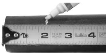
Figure 5A – Valiéndose de una cinta métrica, marque la profundidad hasta donde debe insertarse el tubo dentro del acoplador
